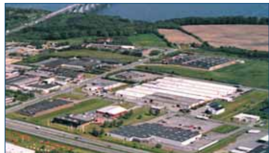
Производственные цеха и научно-исследовательский центр DEVI/Danfoss в г. Вайле, Дания
